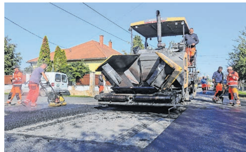
A Nap utca felújítása két ütemben valósulhatott meg
